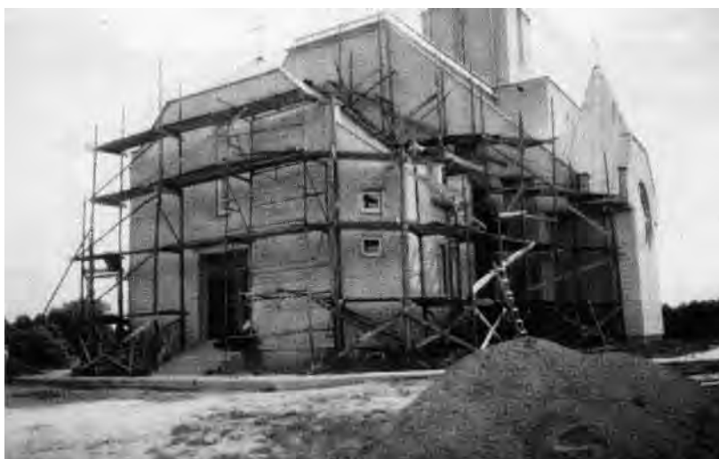
Jau išryškėję naujai statomos Kryžių koplyčios kontūrai
